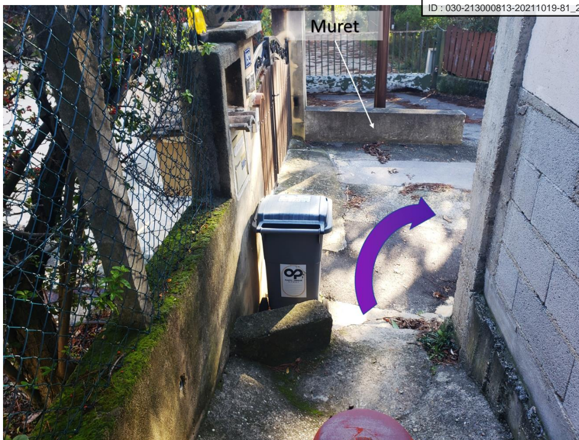
Figure 18 : Vue vers l'aval de la fin de la section bétonnée et du muret construit pour dévier les écoulements
