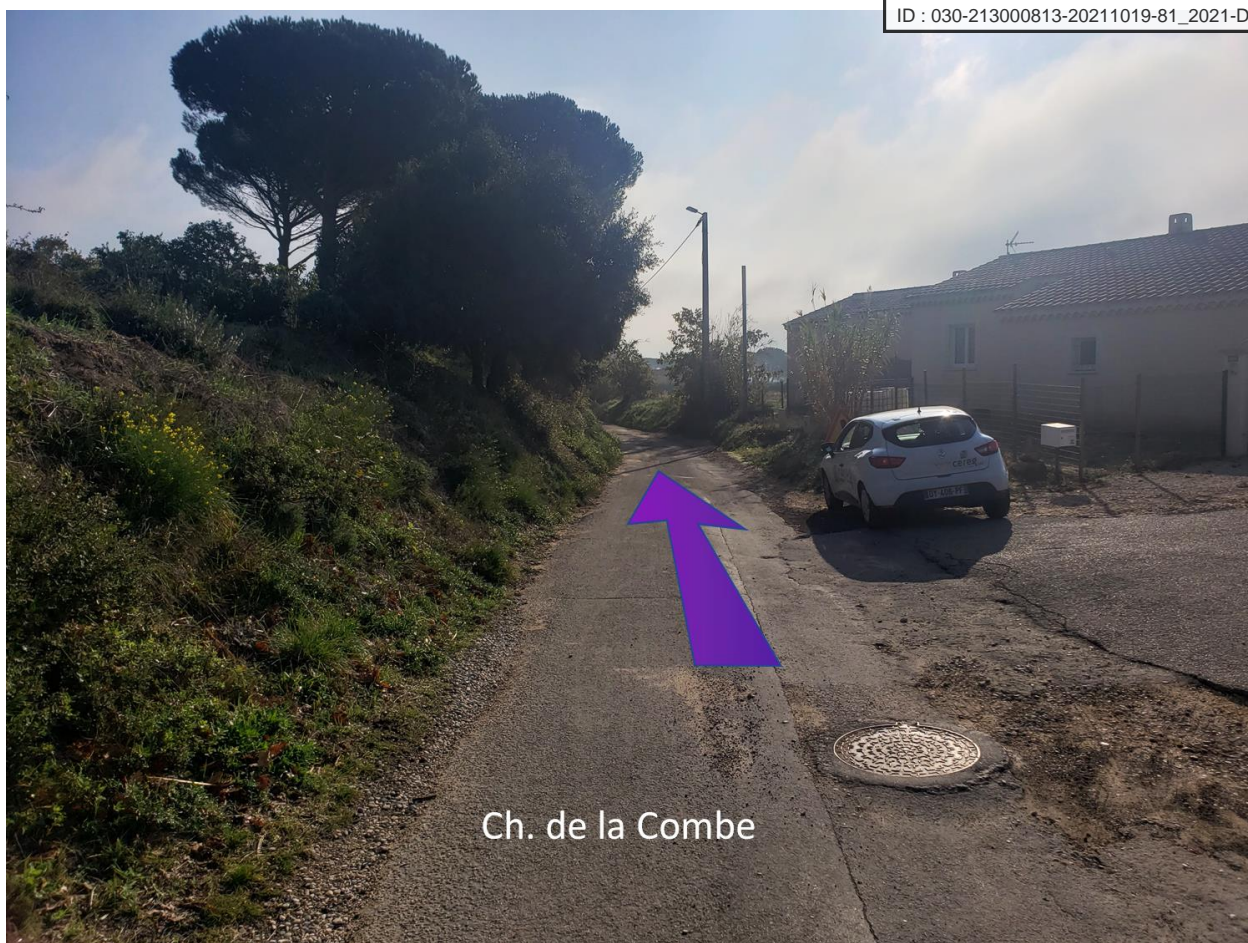
Figure 14 : Vue vers de la zone de ruissellement chemin de la Combe
