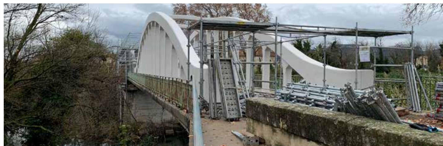
Application LHM sur arc côté amont
