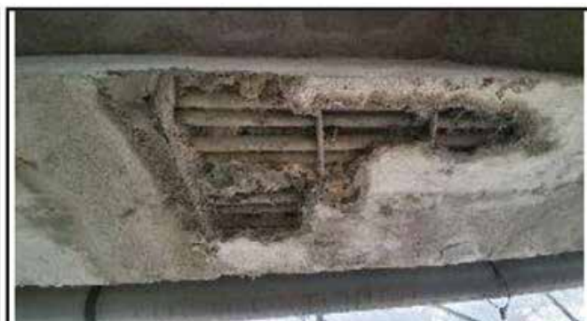
Réparation cavité poutre
