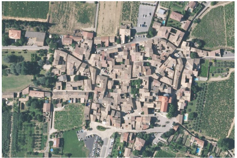
Dans le bâti ancien « tout se touche ».
