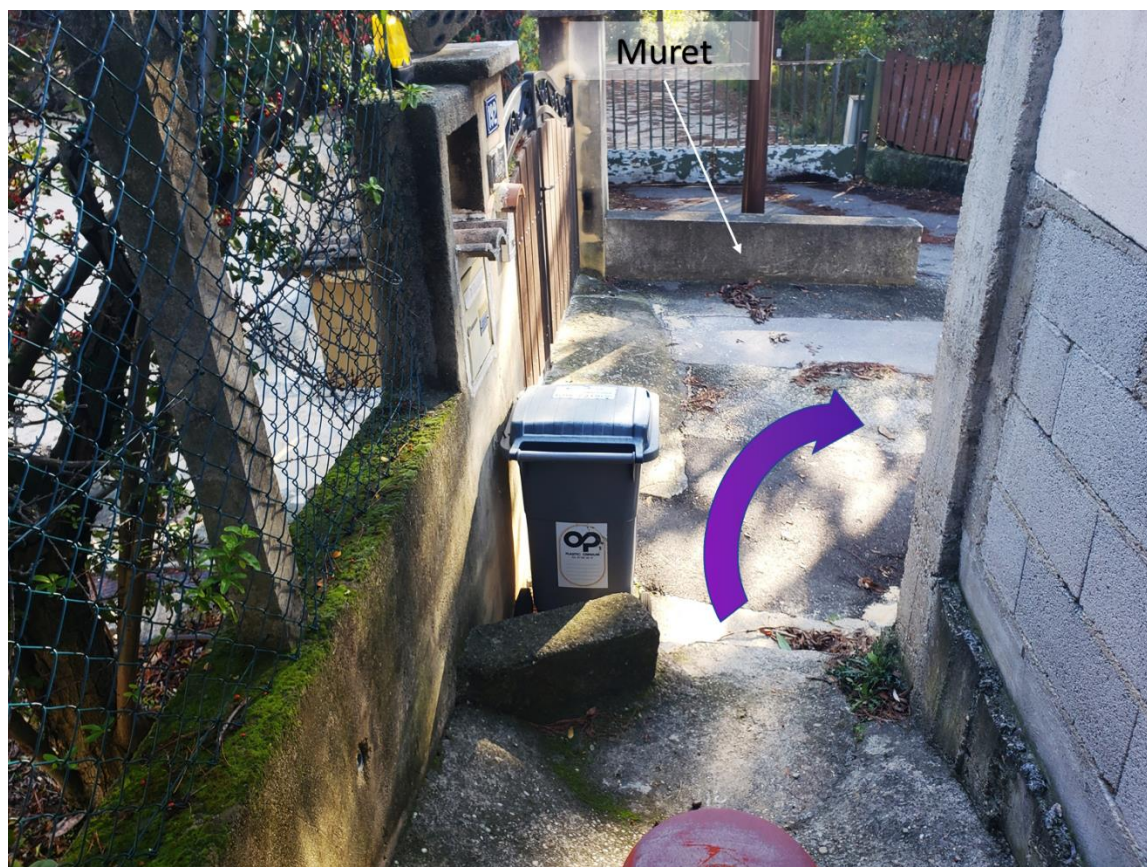
Figure 18 : Vue vers l'aval de la fin de la section bétonnée et du muret construit pour dévier les écoulements
